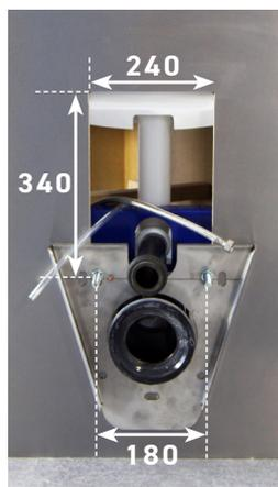
Fijar la placa de soporte del inodoro en las barras roscadas del bastidor con arandelas y tuercas.
