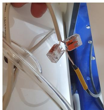
Conectar los hilos desnudos del cable eléctrico a los conectores WAGO pasándolos por el agujero central detrás de la placa.
