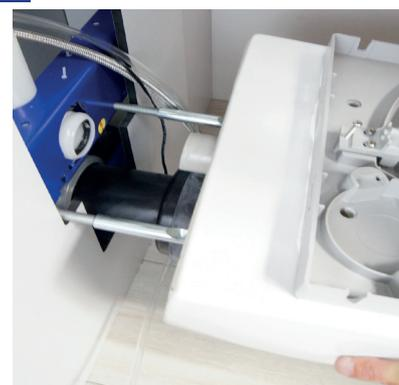
Después de colocar los manguitos con retén labial (instrucciones Geberit), ubicar el inodoro en las fijaciones.
