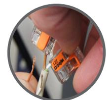
Brancher le câble électrique fils nus sur le câble avec connecteurs WAGO en passant par le trou central à l'arrière de la platine.
