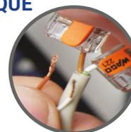
Brancher le câble électrique fils nus sur le câble avec connecteurs WAGO à l'arrière de la platine.
