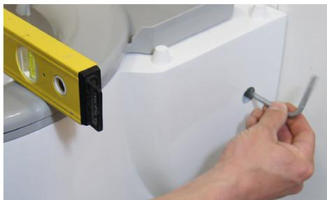
Bloquer la cuvette à l'aide des 2 vis pointeaux.
